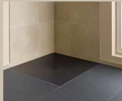
Лишь в заключение, душевой поддон устанавливается в раму и производится полное подключение к арматуре слива. Стыки заделываются эластичным герметиком. Это сохраняет возможность постоянного доступа ко всей конструкции с целью инспекции.
